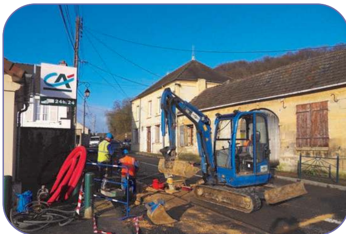
Enfouissement des réseaux Place Tainturier
